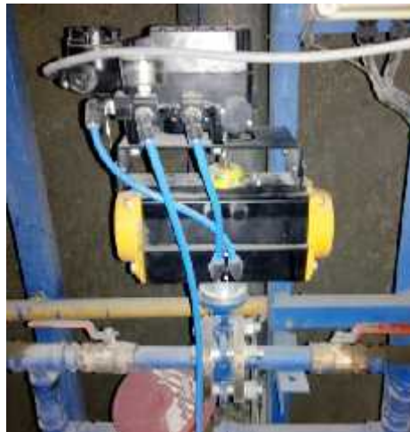
Gambar 5 Assembly Alat Otomatisasi Katup Sistem Aerasi
