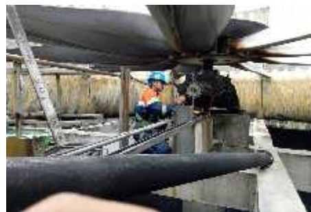
Gambar 3.17 Pengukuran Sudu Fan dan Vibrasi Gear Box
