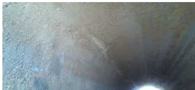
Gambar 3. 5 Pengujian Kamera pada Pipa Bagian III
