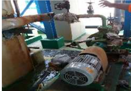
Gambar.4 gambar pompa dan pipa yang korosif
