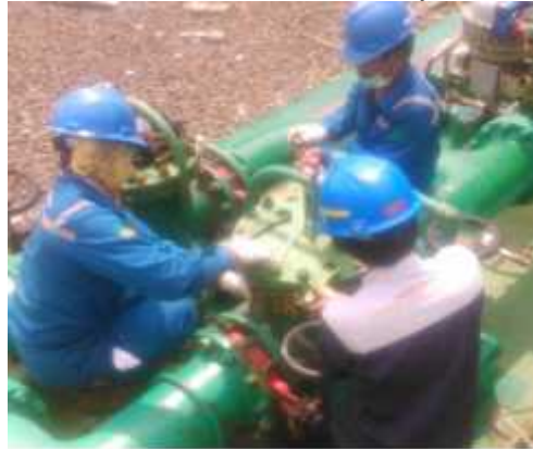
Gambar.6 pembongkaran pada sea water strainer
