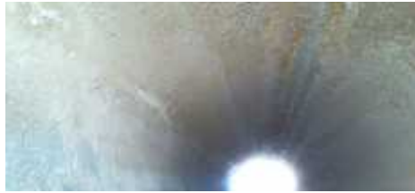
Gambar 3. 3 Pengujian Kamera pada Pipa Bagian I
