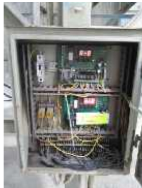
Gambar.1 Pulse controller tidak standard.
