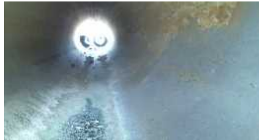
Gambar 3. 4 Pengujian Kamera pada Pipa Bagian II
