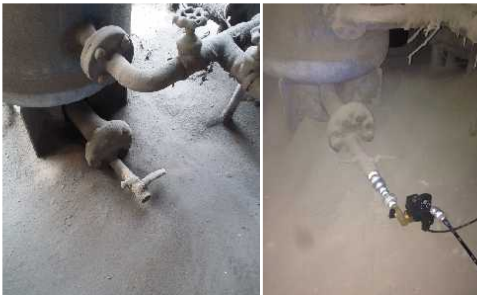
Gambar.7 Sebelum dan Sesudah Instalasi Auto Drain pada Tangki V93-PV1
