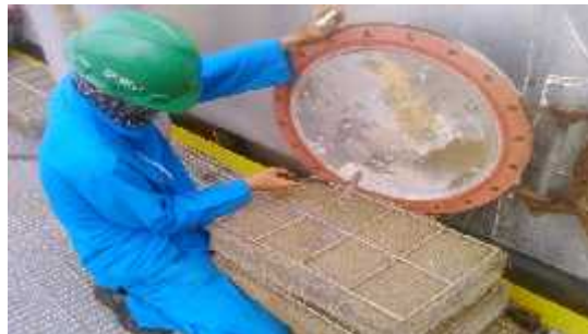
Gambar.3 kerak pada dinding main hole flash evaporator
