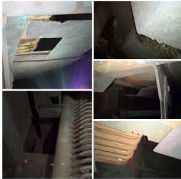
Gambar 4. Kerusakan baffle plate HRSG 1.1
