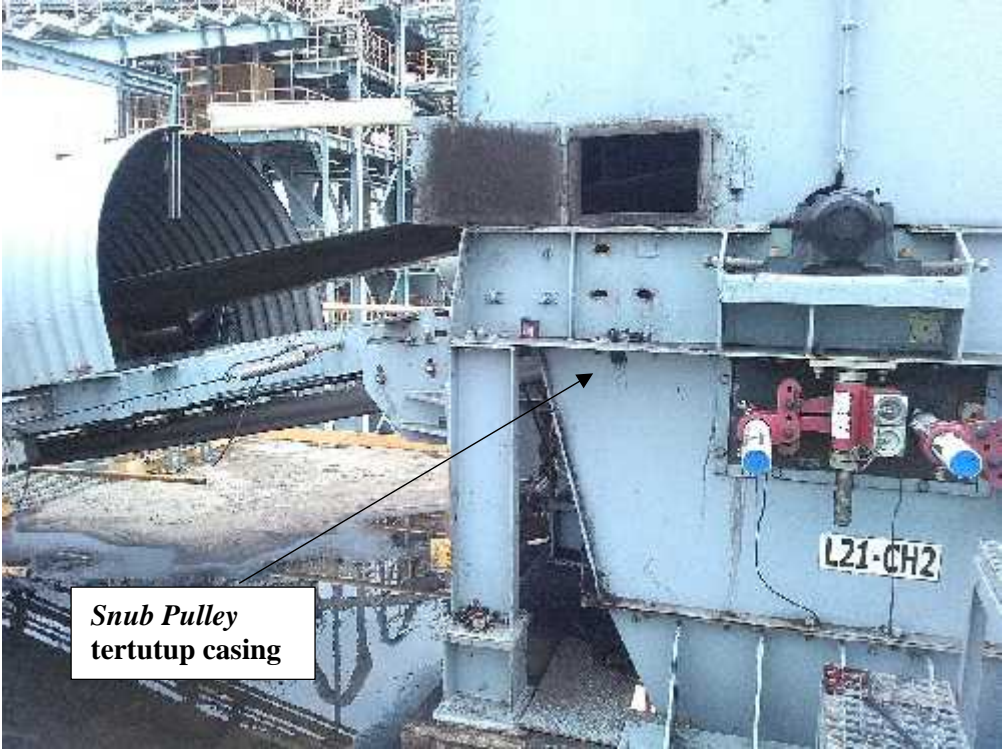
Gambar 1 . Kondisi Head Station Sebelum Di Modifikasi
