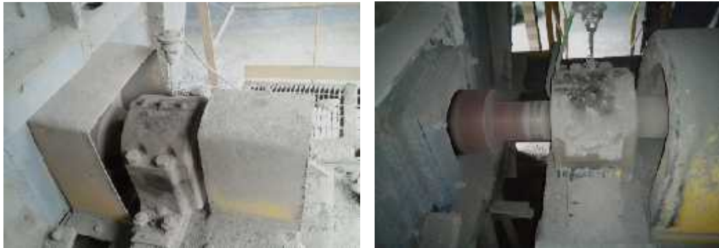
Gambar 1.(a) Bearing Floated Side dari ID Fan 542-FN1 dan 1.(b) Bearing Fixed Side dari ID Fan 542-FN1
