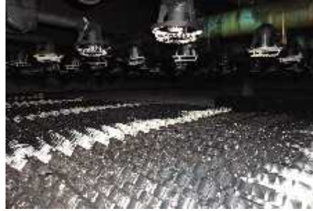
Gambar 3.20 Kondisi Filler Sebelum Pergantian Sumber: PLTP PT. PGE Kamojang Unit IV
