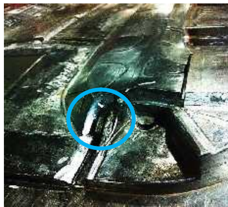
“Gambar.4 Lokasi Kerusakan pada Dinding Hole pada Core”
